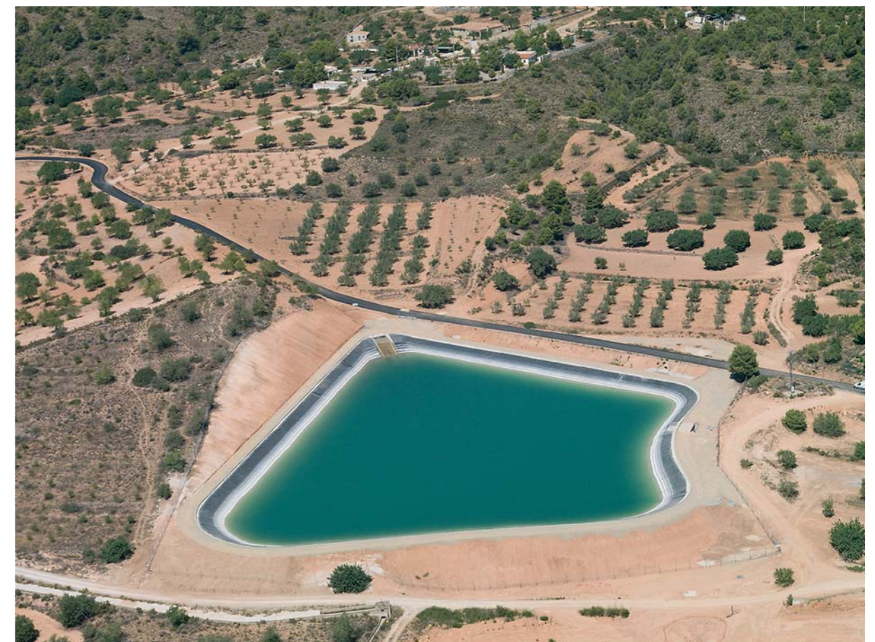
• Obras para la comunidad de regantes de Olocau (Valencia). • Works for the irrigation community of Olocau (Valencia).
