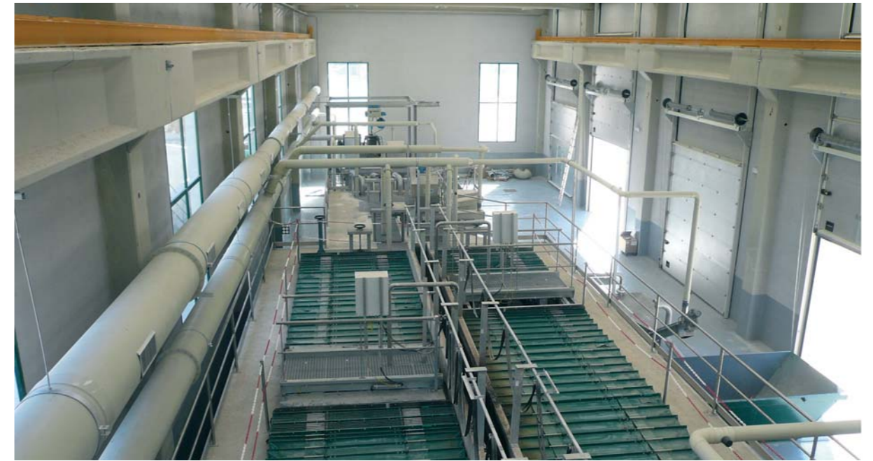
• Edificio Pretratamiento, E.D.A.R. Albaida (Valencia). • Pretreatment building, E.D.A.R. Albaida (Valencia).
