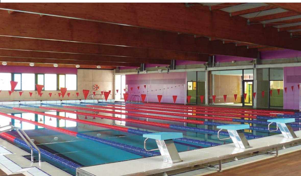
• Piscina cubierta en el Centro de Tecnificación del Deporte, Vila-Real (Castellón). • Covered swimming-pool in the Sports Center of Vila-Real (Castellón).
