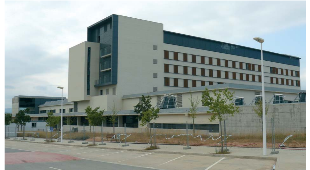
• Hospital Comarcal de Liria, Liria (Valencia). • The hospital of Liria (Valencia).
