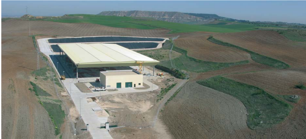
• Vertedero de fangos en Loeches (Madrid). • Landfill sludge in Loeches (Madrid).
