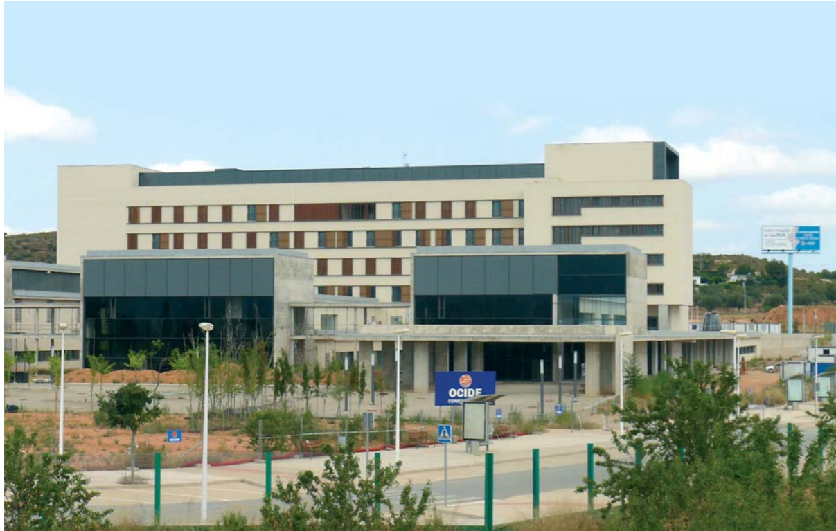
• Hospital Comarcal de Liria, Liria (Valencia). • The hospital of Liria (Valencia).
